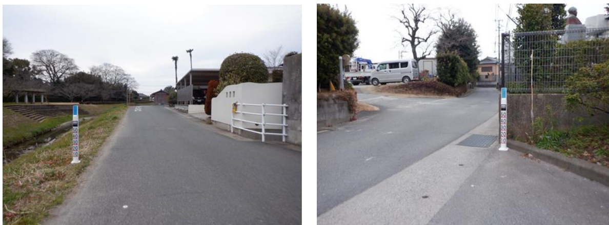
写真 4- 12 水位標設置状況
