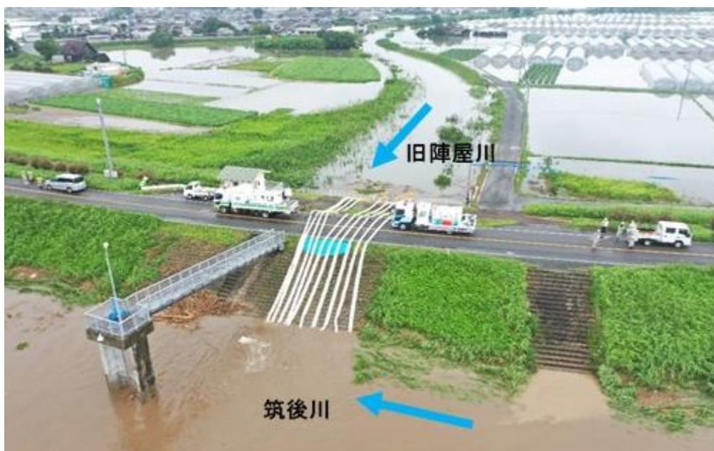
写真 4- 9 排水ポンプ車の活用状況
